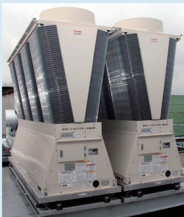
▲ 空冷ヒートポンプ式熱源機「ユニバーサルスマートX」
